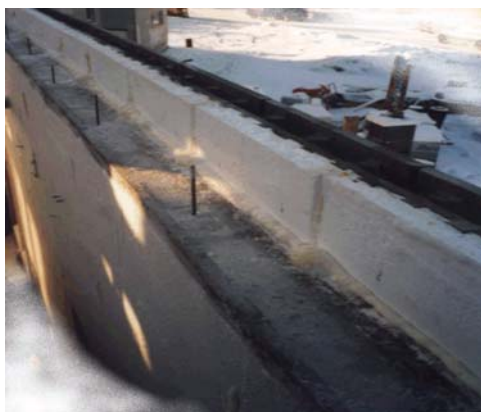
Kuva 13. Ulkoseinän valmistelu välipohjan kiinnittämistä varten valmiiksi halkaistulla harkolla.
