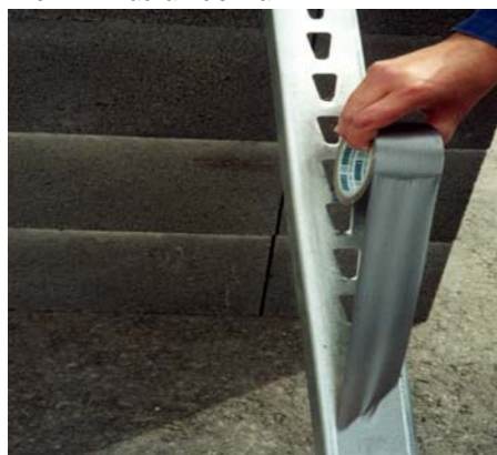
Kuva 10. Profiilin alapinta voidaan teipata umpeen ennen asennusta.
