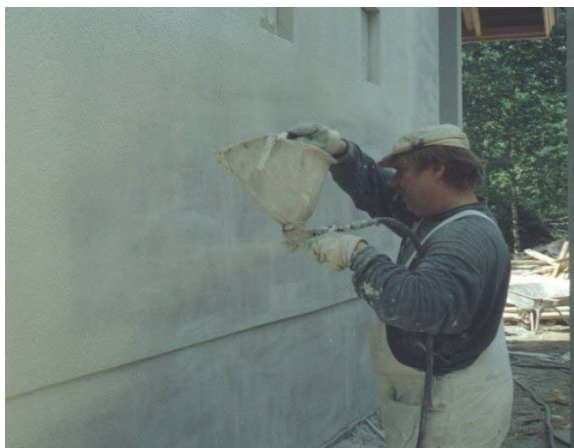
Kuva 16. Rappaus on tarkkaa puuhaa. Oikaistun pinnan päälle ruiskutetaan väripigmentin sisältävä julkisivulaasti.
