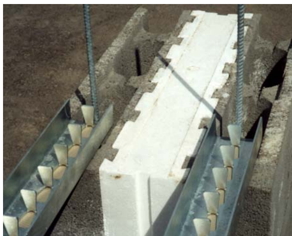
Kuva 9. Aukkojen pielet ja ylitykset on helppo ja nopea tehdä päätyharkolla ja liittoprofiililla.. Teräsprofiili lepää ladontavaiheessa päätyharkon reunan päällä noin 120 mm.
