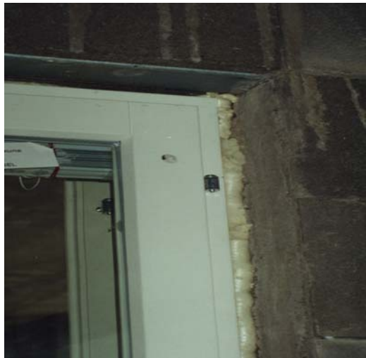
Kuva 18. Ikkuna on kiinnitetty uretaanivaahdolla.
