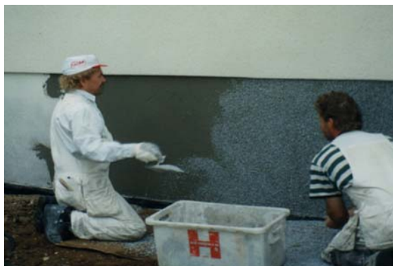
Kuva 15. Rouhe 'heitetään' kiinni oikaistun pinnan päälle levitettyyn kiviliimaan.
