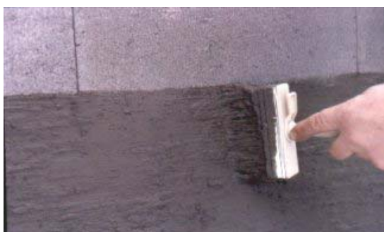
Kuva 14. Slammaus tehdään harjaamalla sementtiliima valmiin rakenteen pintaan.
