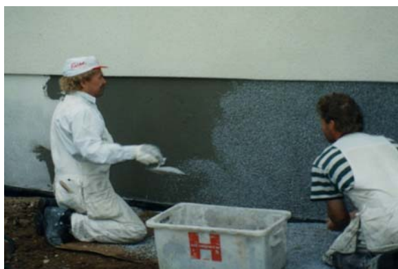
Kuva 11. Rouhe 'heitetään' kiinni oikaistun pinnan päälle levitettyyn kiviliimaan.
