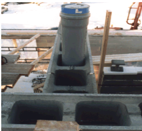
Kuva 7. Seinän sisään mahtuu isompikin putki.
