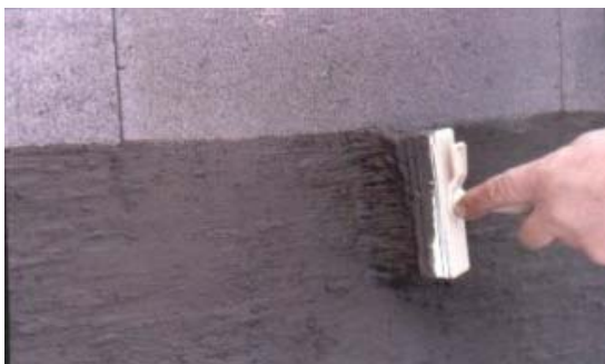
Kuva 10. Slammaus tehdään harjaamalla sementtiliima valmiin rakenteen pintaan.
