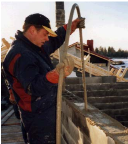
Kuva 9. Tiivistämiseen käytetään tärysauvaa. Sauvan käyttö edellyttää tekijältä rauhallisia liikkeitä, jotta riittävä tiivistymisen saadaan aikaiseksi.
