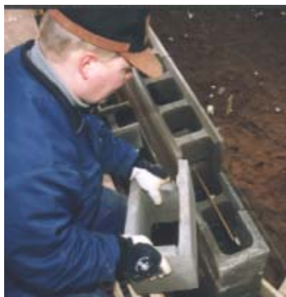
Kuva 2. Valmiilla päätyharkoilla päädyn ladonta onnistuu vaivattomasti. Pääty tulee tukea hyvin valua varten.
