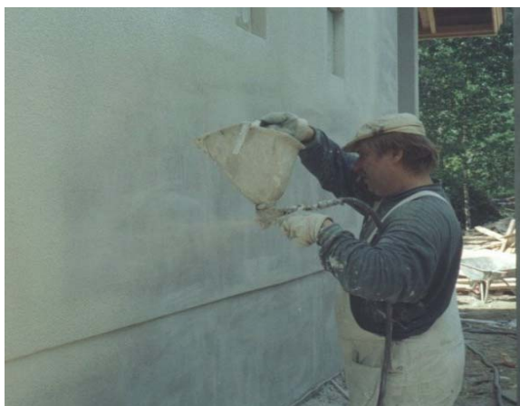
Kuva 10. Rappaus on tarkkaa puuhaa. Oikaistun pinnan päälle ruiskutetaan väripigmentin sisältävä julkisivulaasti.
